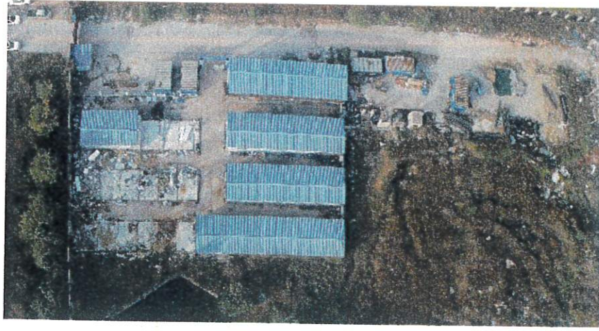
临时道路、临时办公区现状照片
