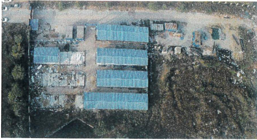
临时道路、临时办公区现状照片
