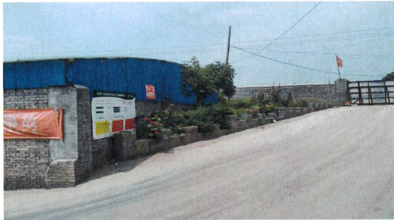
图1 厂区房屋周边绿化现状图
