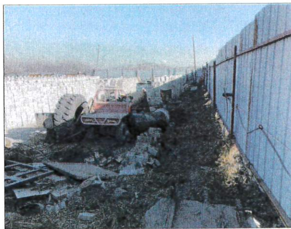
图3 厂区东南侧花池现状图
